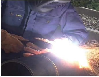
Remoção da solda
